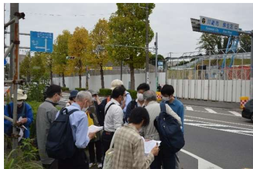
写真1 ブルーライン新駅予定地ならびにリニア中央新幹線非常口工事現場(道路の向こう側が非常口工事の現場です)
