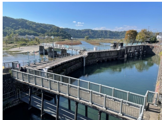
図7 玉川上水取水堰 (ただし、下見時(10月28日)の写真)
