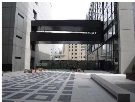
写真4 大内山校舎3階とゲート棟3階がブリッジで連結
